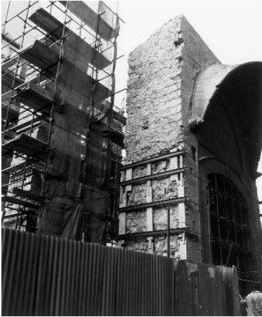
Imbracature metalliche interne ed esterne del portale per garantirne la stabilità (sopra e sotto).
