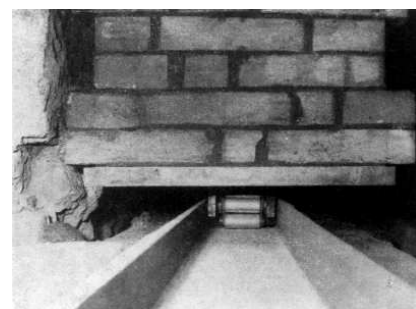
Paranchi a mano per spostare il portale, rulli e guide metalliche con cuscinetti (a lato), e (sopra) la struttura in fase di traslazione.
